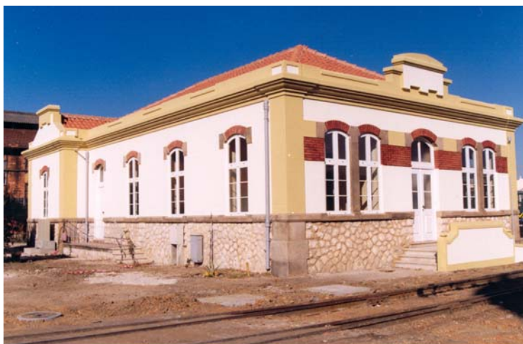
Fig. 7 - Edifício da Sede Nacional do MNF (Foto de P. Pires)
