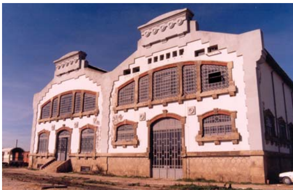
Fig. 12 - Central Eléctrica (Foto de P. Pires)
