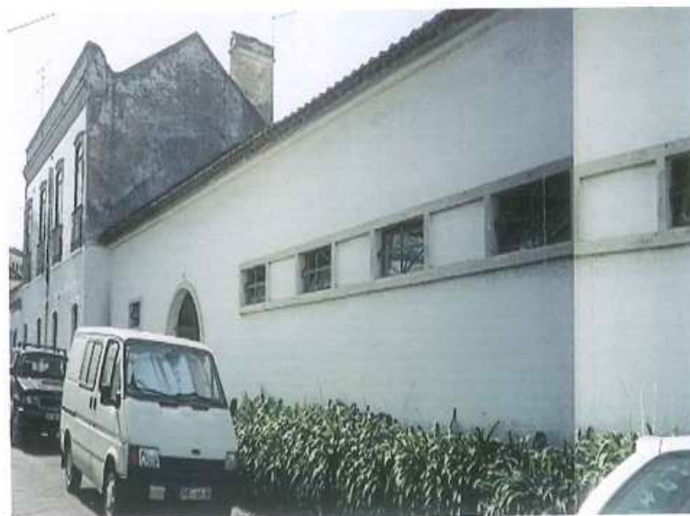
Figura 2.- Parte da fachada principal, rua 1º de Maio. (estado actual)
