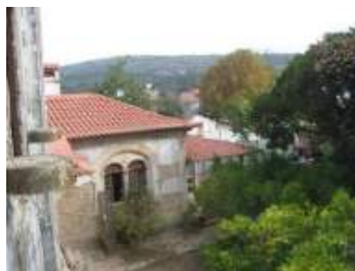
Figura 59– Aspecto da fachada principal antes das obras de recuperação. (fotografia – arquivo do CAORG)
