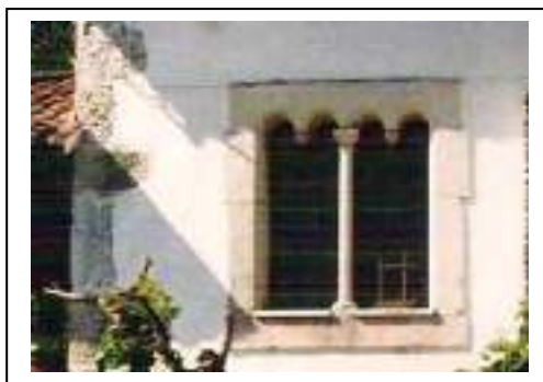
Figura 55 – Pormenor da janela dupla da sala principal da Casa dos Açores. (fotografia – arquivo do CAORG)
