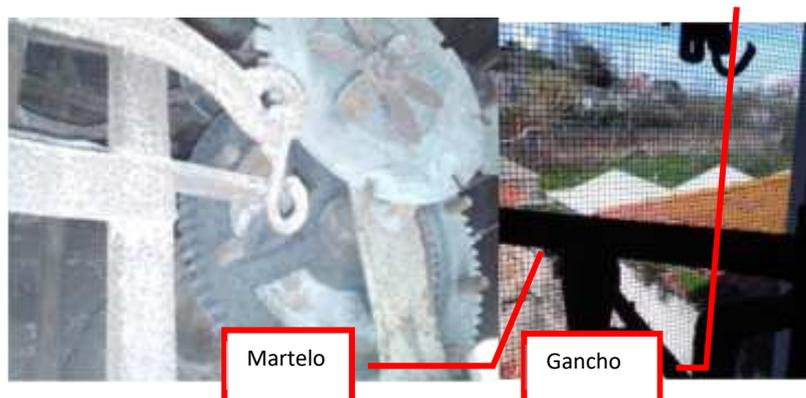
Fig. 27 - Interior do relógio (esq), martelo e gancho onde estava pendurado o sino (dir) (Fotos do autor)
