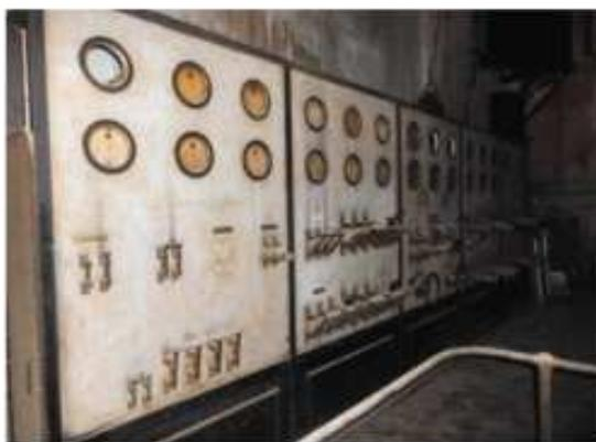
Fig. 61 - Painel de controlo de corrente eléctrica (Foto do autor)
