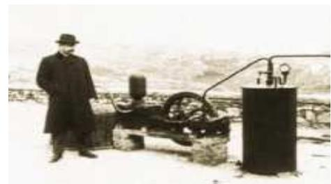
Fig. 121 - Piero Ginori e o seu invento de gerar eletricidade com vapor geotérmico.
