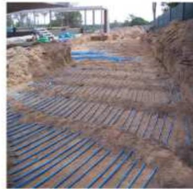
Fig. 72 - Exemplo de colocação das sondas horizontais em obra
