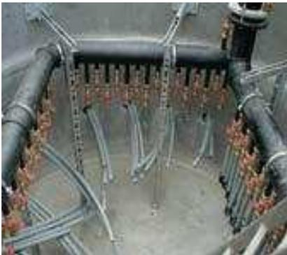
Fig. 77 - Sondas nas estacas da fundação do edifício após a betonagem.
