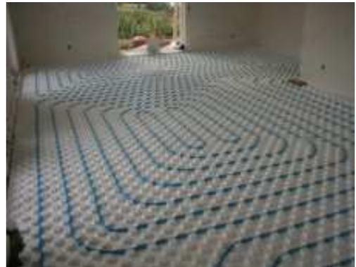
Fig. 81 - Circuito de tubagem de piso radiante com termoplaca.
