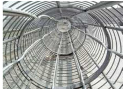
Fig. 78 - Sondas nas estacas da fundação do edifício, antes da betonagem.
