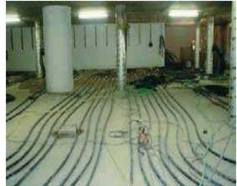
Fig. 96 - Sistema de bombas de calor. Estação do metro de Madrid. Fonte: D. G. E. y M. C. Madrid "Proyectos Emblemáticos en el Ámbito de la Energía Geotérmica",
