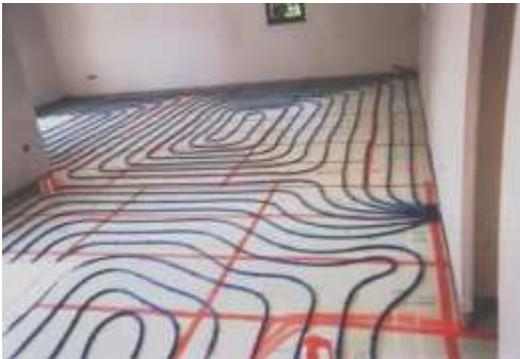
Fig. 80 - Circuito de tubagem de piso radiante
